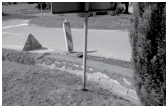
Sanacija meteornegega kanala na Gortini ob restavraciji Mesar (2.000 €).
