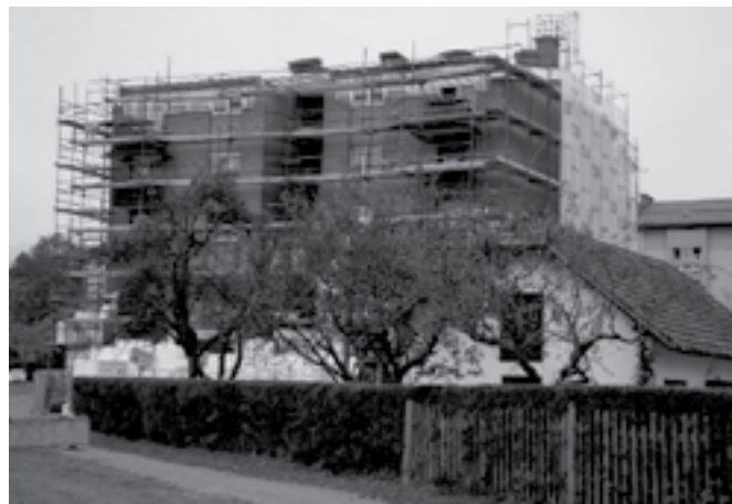
Sanacija fasade bloka na Zg. Muti (cca. 90.000 €).
