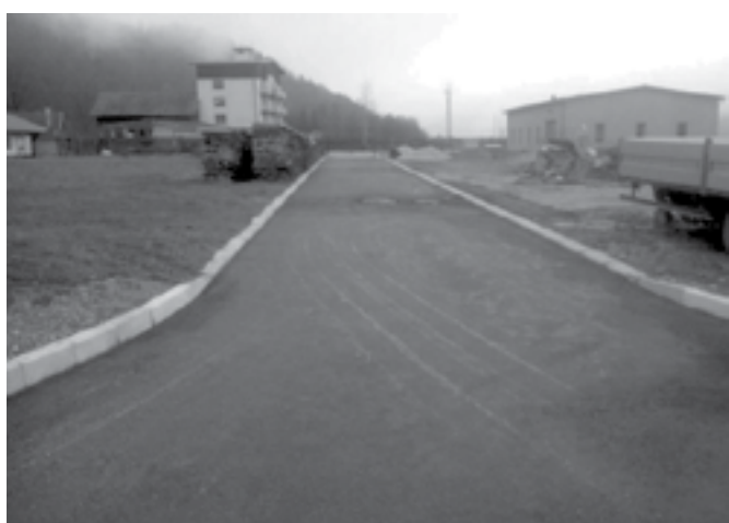
Obrtna cona – dokončanje (48.000 €).
