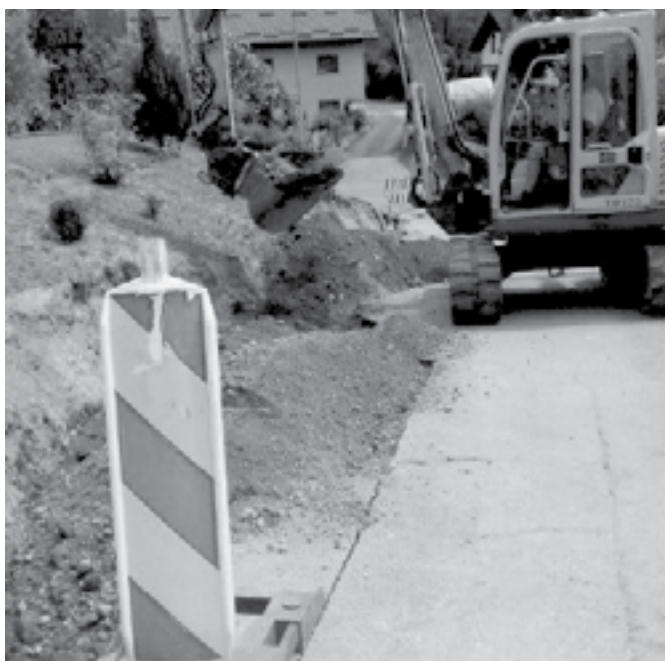
Sanacija vodovoda na klancu (8.000 €).
