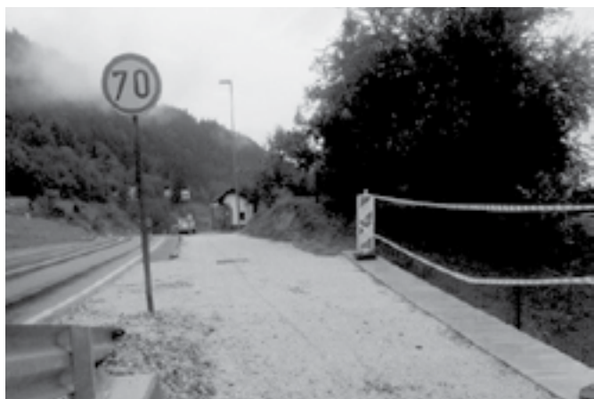
Izgradnja dela kolesarske steze (Gortina/Vrata) – 13.000 €.
