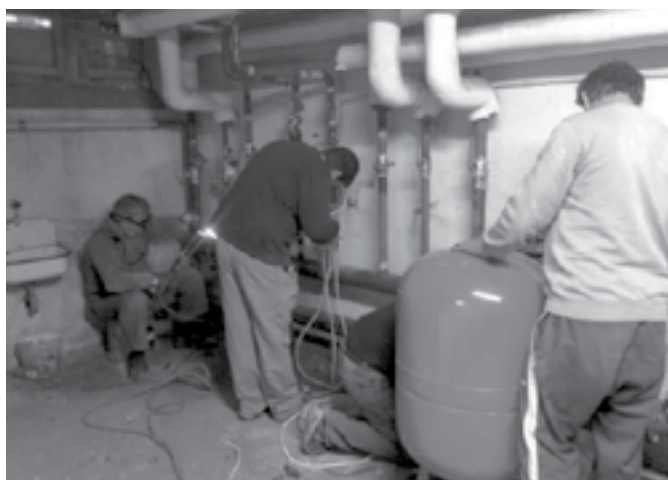
Obnova kotlovnice na Glavnem trgu 31.
