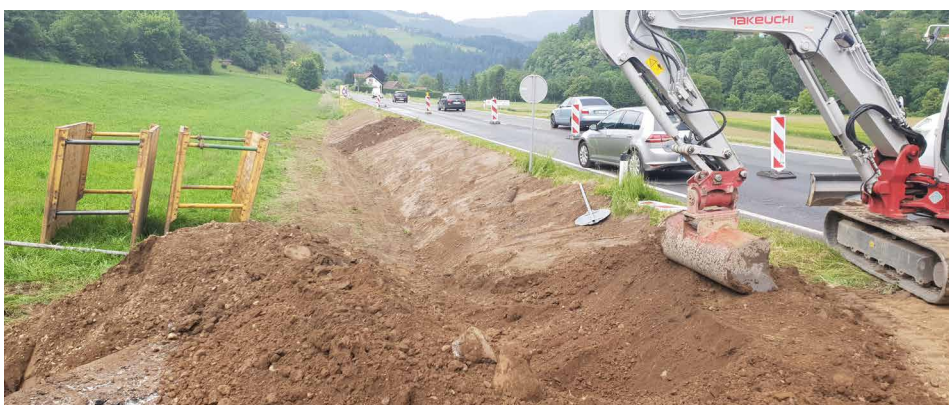
Delo na območju Gostišča pri Izidorju
