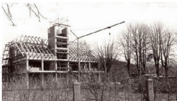
Faze gradnje novega gasilskega doma na Muti
